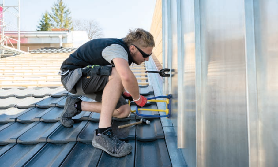
◀ Adrian de Graaff bringt hier seitlich des Dachfensters die Blechverkleidungen an.
